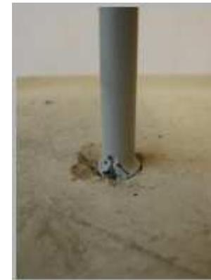
Ancrage nominal  $h_{v \text{ nom}}$ : 35mm, ancrage effectif  $h_{v \text{ eff}}$ : 30 mm, prof. de perçage  $h_1$ : 45 mm
