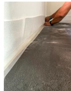
Cette chape innovante bénéficie d'un Marquage CE selon NF EN 13813 : CT-C12-F3, assurant ainsi sa conformité aux normes de qualité et de sécurité en vigueur. Sa réaction au feu est classée A<sub>2</sub>-s1, garantissant une sécurité optimale.
