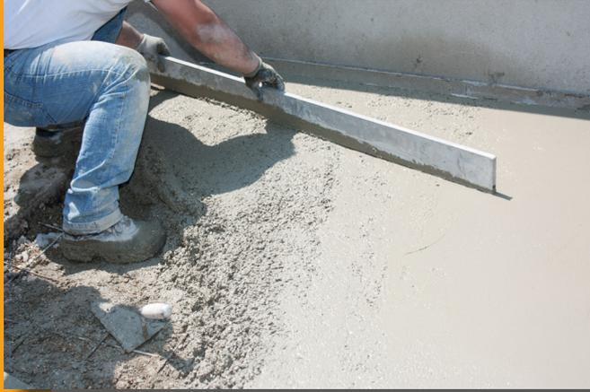
POLYS BÉTO<sup>®</sup> se met en oeuvre très facilement. Sa consistance mousseuse permet une application simple et efficace lors de la mise à niveau et la confection de supports de revêtements prêts à recevoir directement un carrelage collé ou autre.
