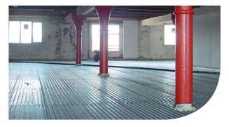
Les profilés LEWIS® sont des bacs en acier nervurés en forme de queue d'aronde.
