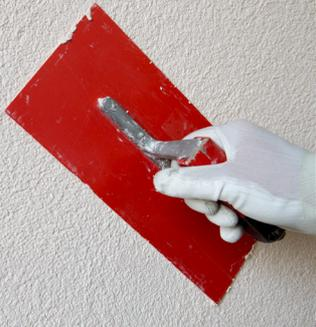
L'**ECAP**<sup>®</sup> **AC « Acrylic Colour »** se prépare à l'aide d'un malaxeur à faible vitesse. Sa consistance pâteuse facilite son application qui doit être travaillée de manière régulière et sans interruption.
