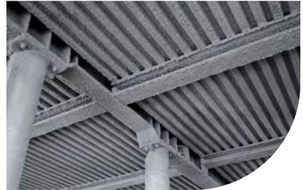
*PROTHERM Light® ne contenant pas de fibre, ce mortier solide (une fois sec) ne se désagrège pas quand on le touche, et présente donc un caractère de forte stabilité et durabilité.*
